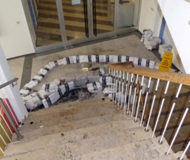
Bild li.: Dämme aus Kopierpapier zur Ableitung des Löschwassers im Treppenhaus des Neubaus; Bild re.: Der Große Sitzungssaal des Rathauses nach dem Brand.
