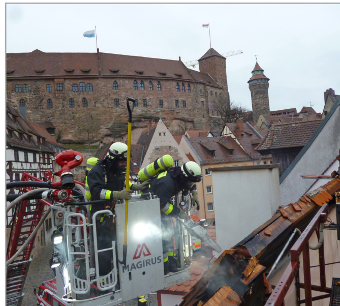
Bild 1: Systematisches Öffnen des Dachstuhls mit drei Drehleitern; Bild o. und u.: Erkundung am Dachfirst der Gaststätte
