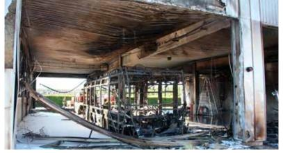
eine große Rolle, da der sogenannte Thermal-Runaway, das thermische-Durchgehen der Batteriezellen, nur durch Kühlung eingedämmt werden kann. Dringt Wasser in die Zellen ein, reagiert dieses mit den Aktivmateralien, wodurch diese deaktiviert werden und dann nicht mehr weiter zu einem Brand beitragen können. »Aber wie bekommen wir das Wasser in die Batterie rein?« stellt sich oft die Frage.
